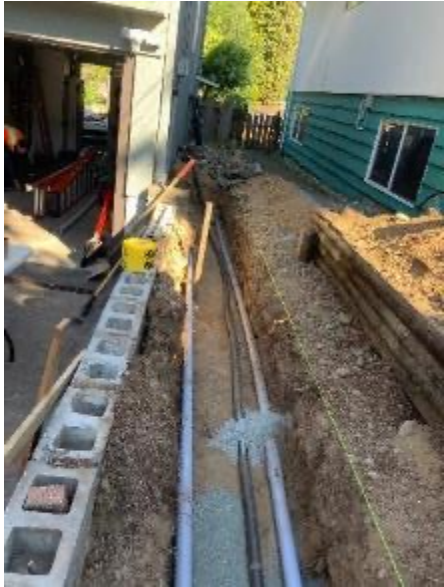
Trenches dug; Conduit buried
